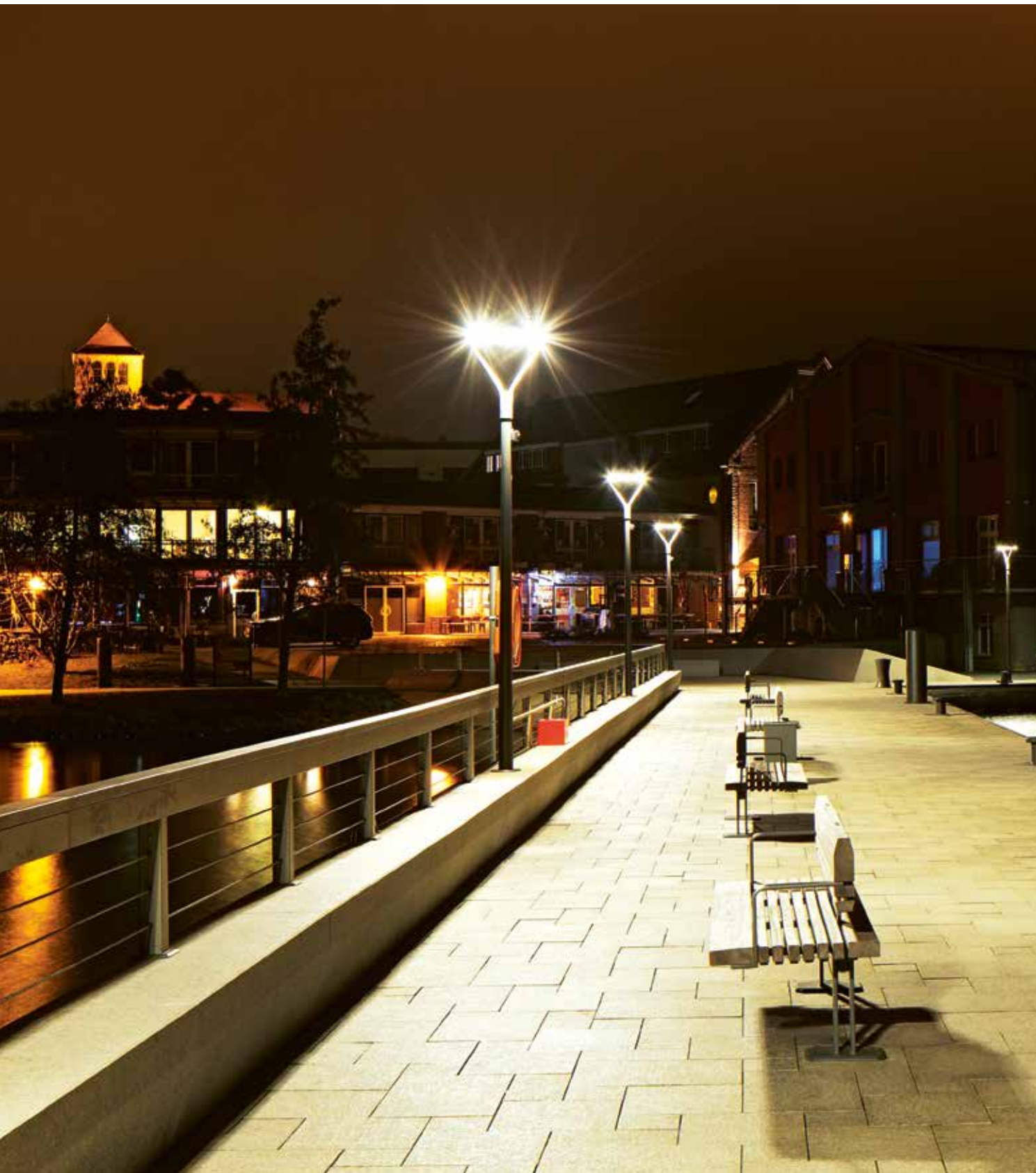
Projet : ville de Waren an der Müritz, Allemagne Produits : DL® 50, DL® 20, Floodlight FL 20
